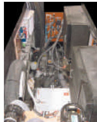
Salle des machines Engine room Sala tecnica Sala de máquinas Maschinenraum
